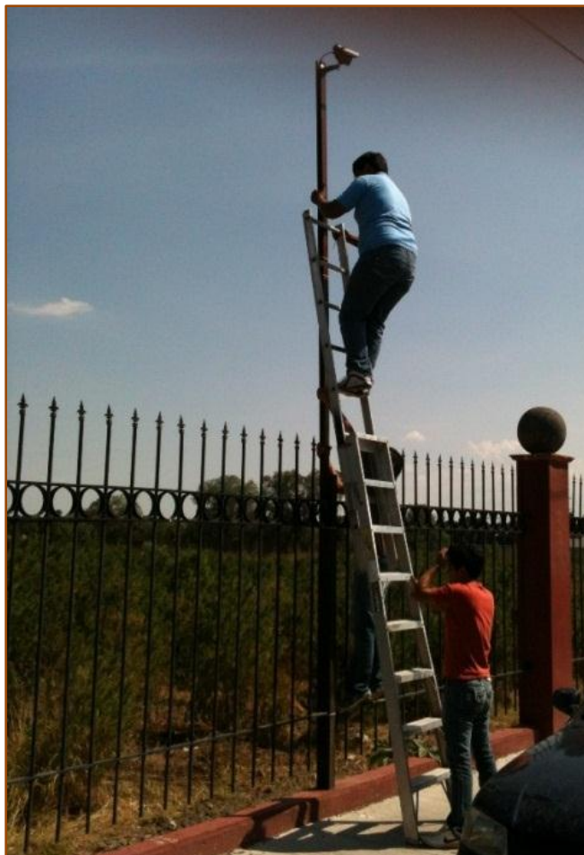
Foto No. 3.2. Instalación de cámara de video – vigilancia, Acceso 1
