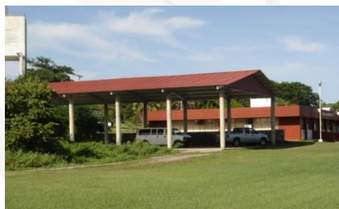
Construcción de Estacionamiento techado para el parque vehicular del Instituto, cubriendo un área de 375 m 2
