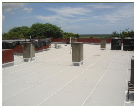
Impermeabilización del Laboratorio de Electrónica
