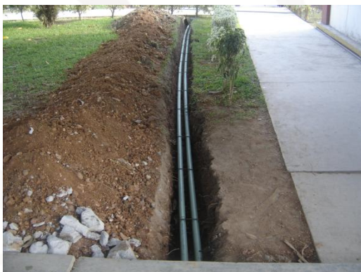
Tendido de Líneas de Fuerza para Suministro de Energía Eléctrica a Edificios "D" y "E"
