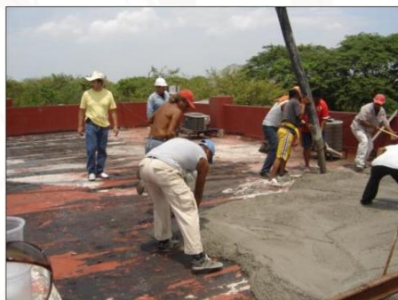
Entortado de Laboratorio de Ingeniería Electrónica
