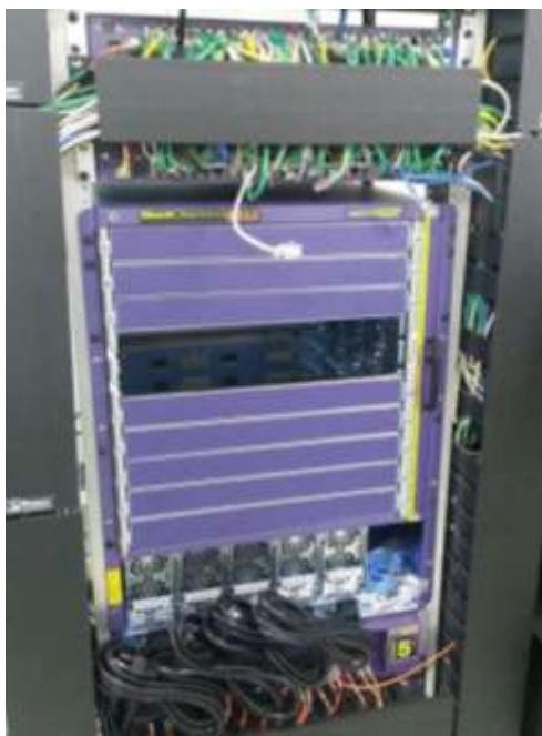
Figura 37.- Switch Core que permite la mejora del servicio de Internet e Internet II.
