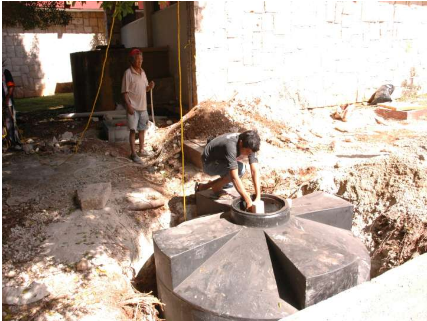
Figura 63.- Instalación de un biodigestor para el tratamiento de aguas residuales.
