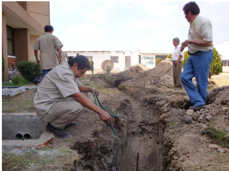
Fig. 9 Tendido de fibra óptica
