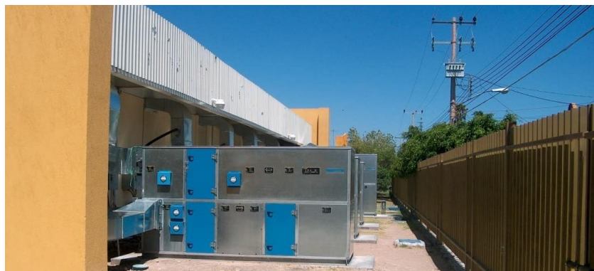
Fig. 10 manejadoras de aire del laboratorio secundario de metrología
