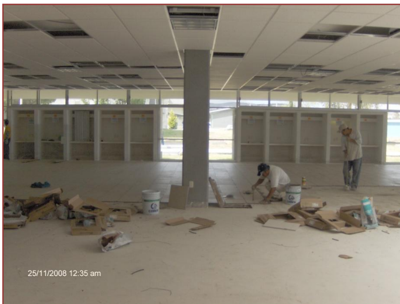
Colocación de piso en el Centro de Información
