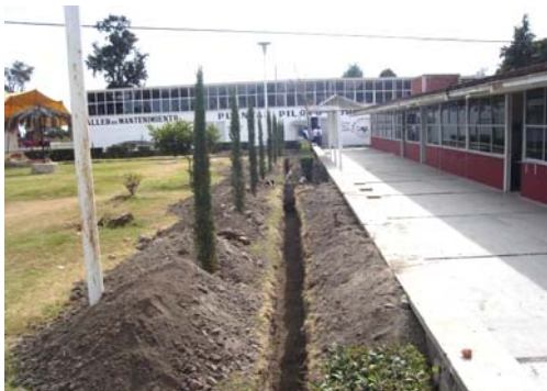
Instalación de RED de fibra óptica
