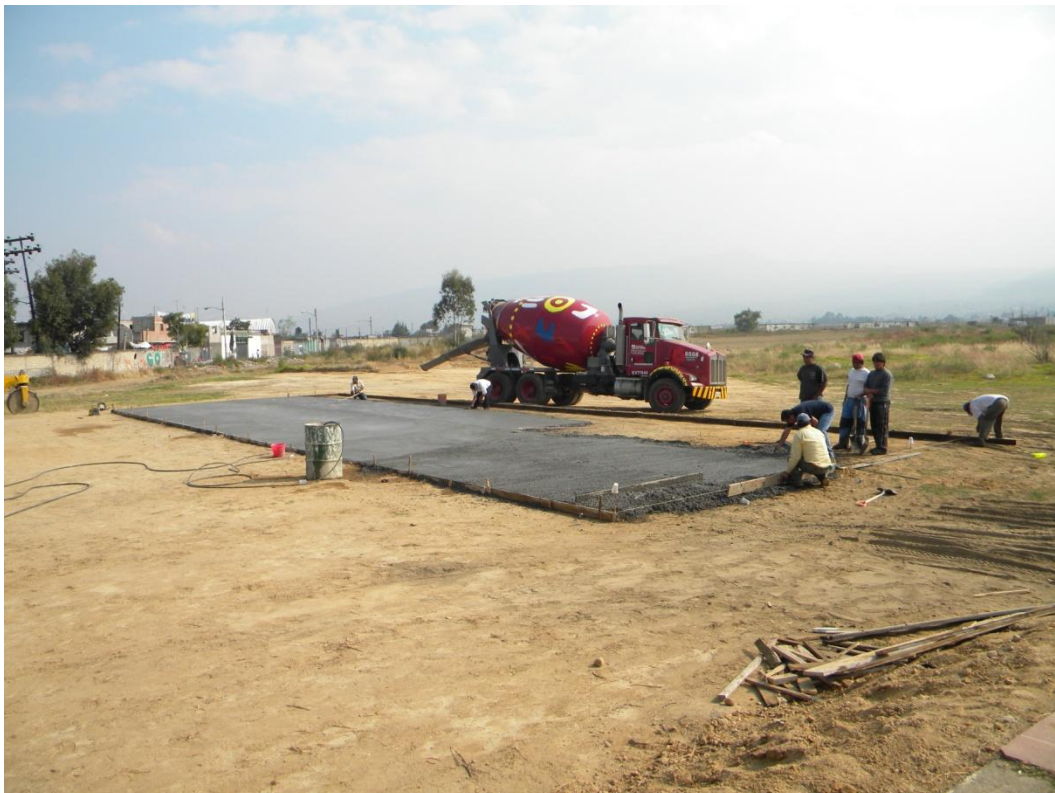
FOTO DE ANTES, DONDE SE OBSERVA EL VACIADO PARA LA CONSTRUCCION DE LA PLANCHA DE CONCRETO PARA LA INSTALACION DE AULAS NUEVAS.
