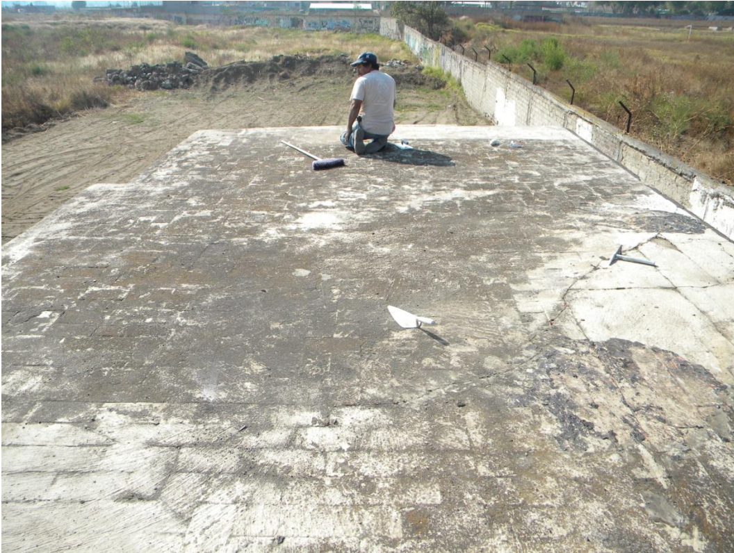
FOTO DE ANTES DE IMPERMEABILIZAR EL TECHO DEL EDIFICIO DE BIBLIOTECA.
