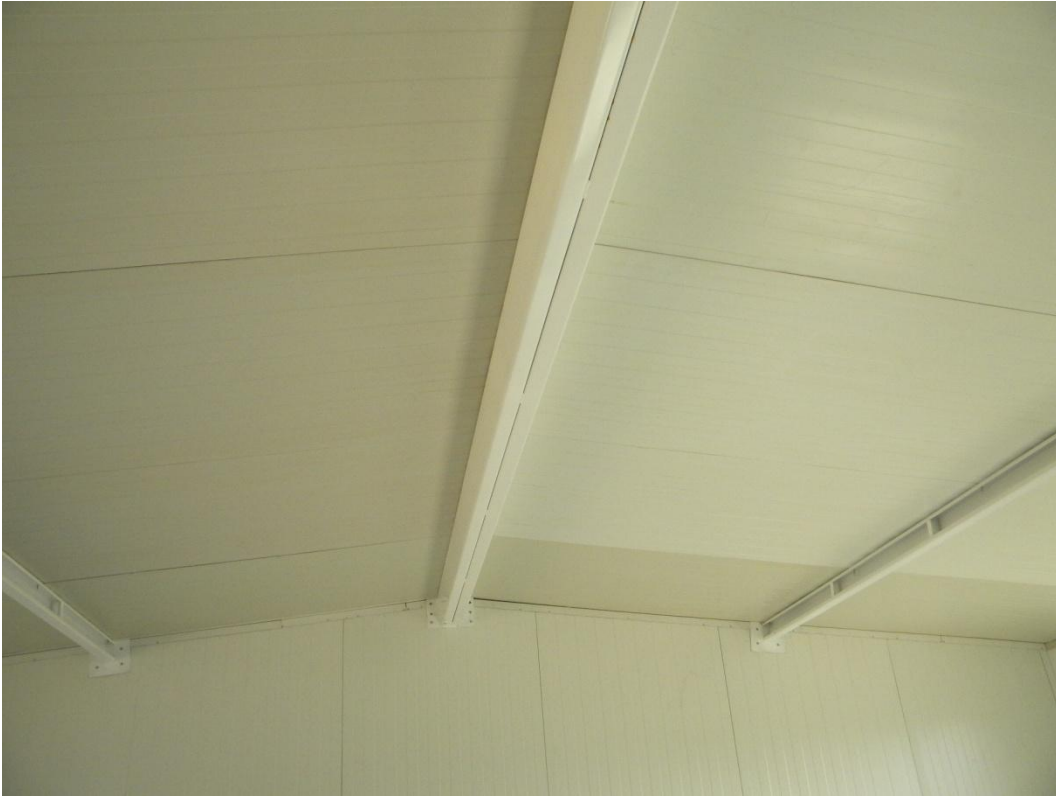
FOTO DE ANTES DE HACER LA INSTALACION ELECTRICA INTERIOR EN LAS AULAS NUEVAS.
