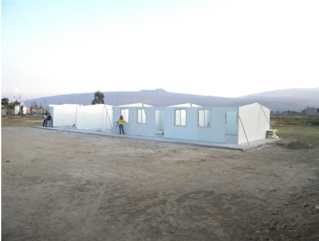
FOTO DEL AVANCE DE EL LEVANTAMIENTO DE LAS AULAS NUEVAS.
