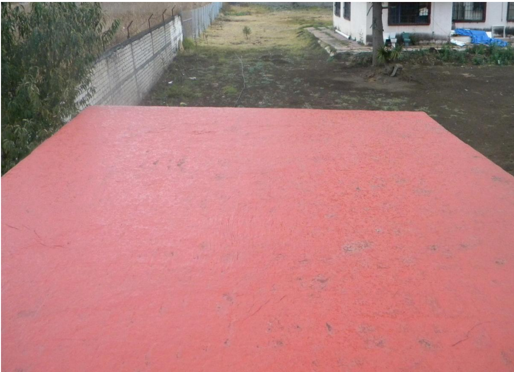
FOTO DE DESPUES DE IMPERMEABILIZAR EL TECHO DEL EDIFICIO DE BIBLIOTECA
