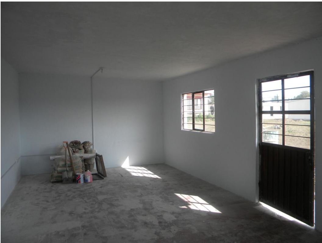
FOTO DE DESPUES DE DAR MANTENIMIENTO CORRECTIVO A PAREDES Y TECHO AL EDIFICIO DE BIBLIOTECA
