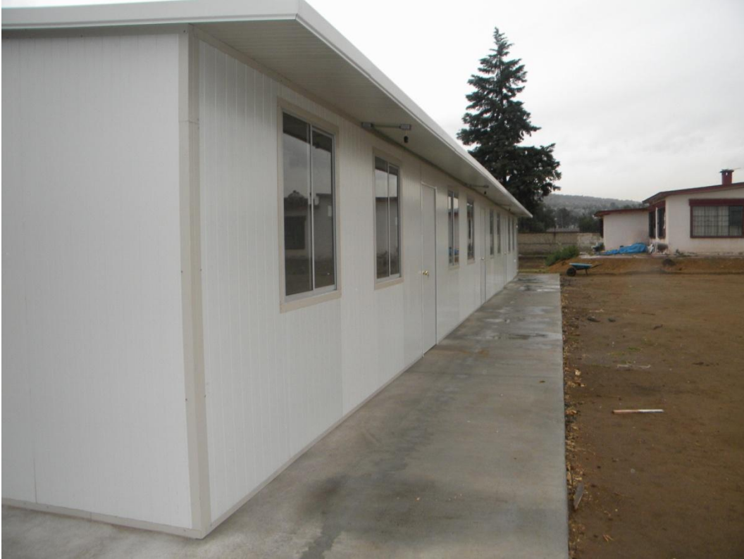
FOTO DE DESPUES DE HACER LA INSTALACION ELECTRICA EXTERIOR EN AULAS NUEVAS.
