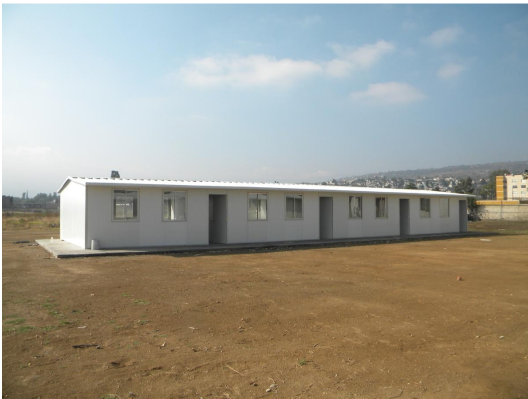
FOTO DE DESPUES LA TERMINACION DE LAS AULAS NUEVAS.
