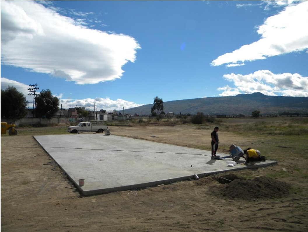
FOTO DE DESPUES DONDE SE OBSERVA LA CONSTRUCCION DE LA PLANCHA DE CONCRETO PARA LA INSTALACION DE AULAS NUEVAS.
