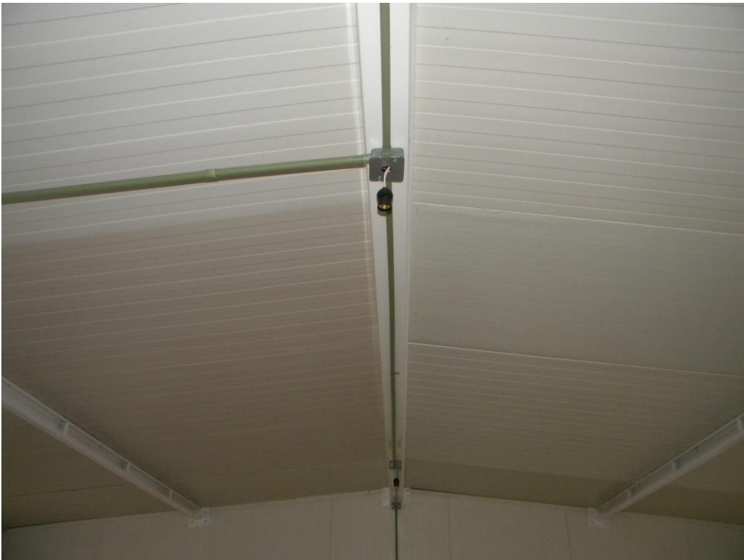
FOTO DE DESPUES DE HACER LA INSTALACION ELECTRICA INTERIOR EN LAS AULAS NUEVAS.
