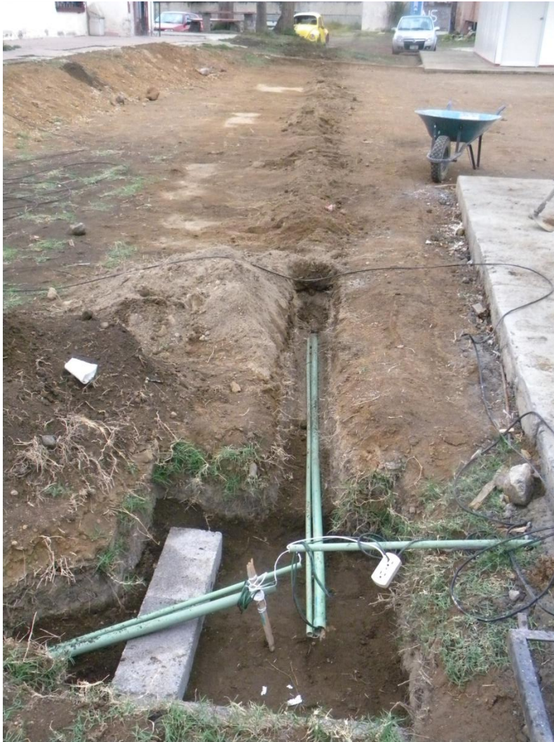
FOTO DE DESPUES DE HACER LA INSTALACION DE TUBERIA Y CABLEADO ELECTRICO PARA ALIMENTAR LAS AULAS NUEVAS Y BIBLIOTECA.
