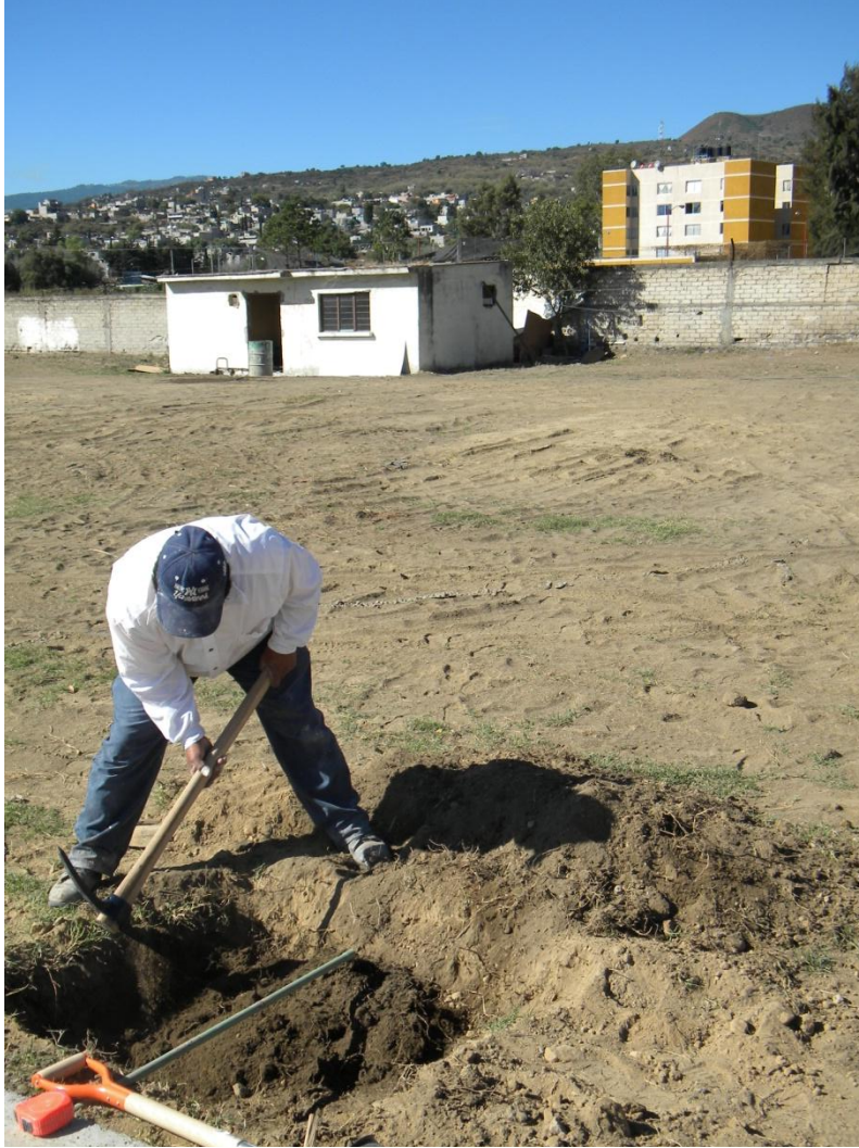
FOTO DE ANTES DE HACER LA INSTALACION DE TUBERIA Y CABLEADO ELECTRICO PARA ALIMENTAR LAS AULAS NUEVAS Y BIBLIOTECA.
