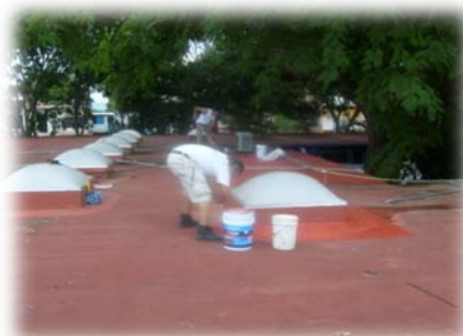
MANTENIMIENTO A EDIFICIOS (IMPERMEABILIZACION)
